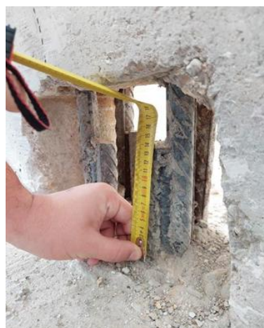
Фиг. 13. Измерване на заваръчен шев
