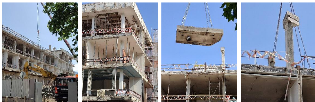
Фиг. 3. Селективно разрушаване на средноетажна офис сграда в гр. София – трети етап
