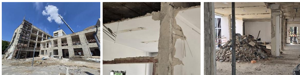
Фиг. 2. Селективно разрушаване на офис сграда – втори етап
