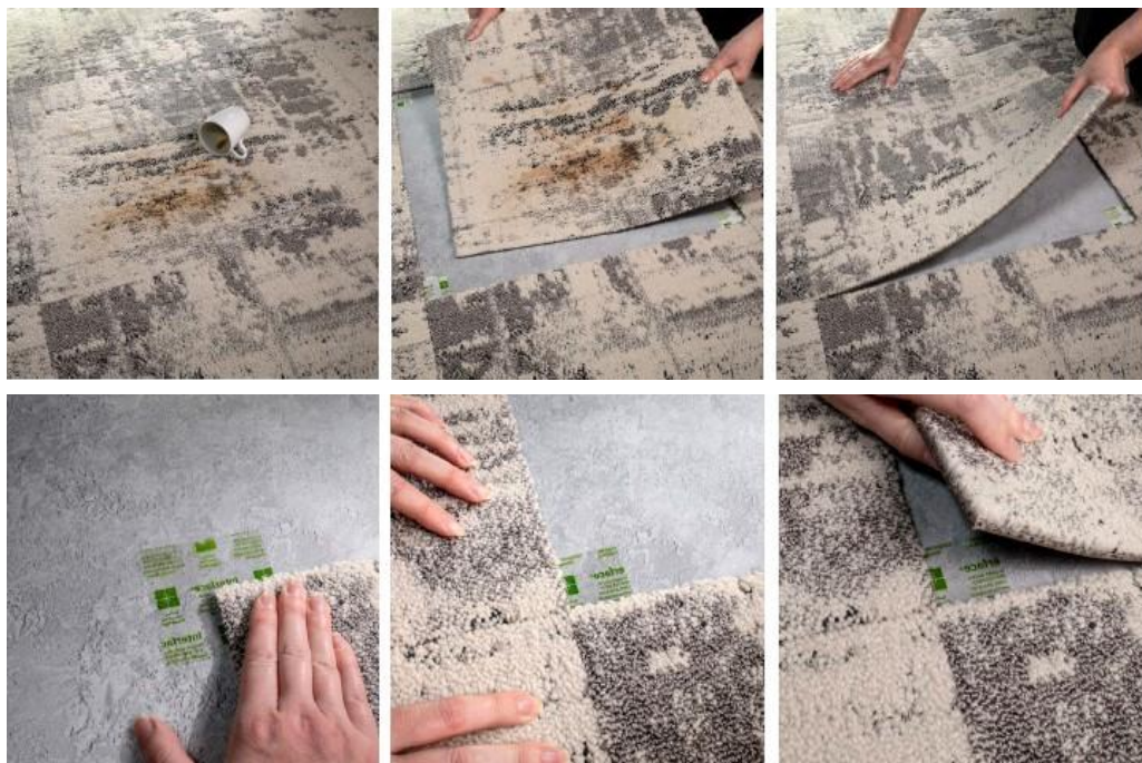
Фиг. 9. Монтаж на модулни настилки чрез съединения TacTiles® без лепило, без съдържание на ЛОС, произведени от рециклирана пластмаса (PET) [22]
