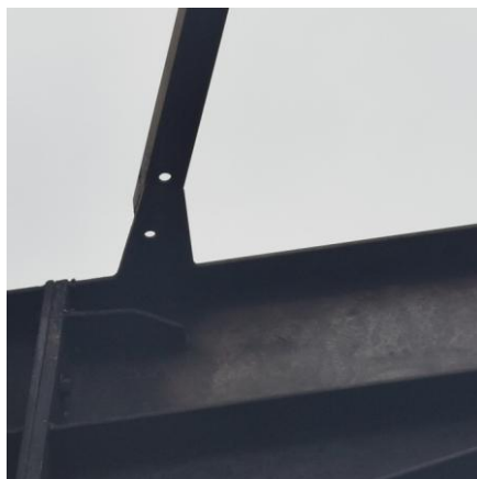
Фиг. 3.5. Елемент от хоризонтална връзка, монтиран с един болт
