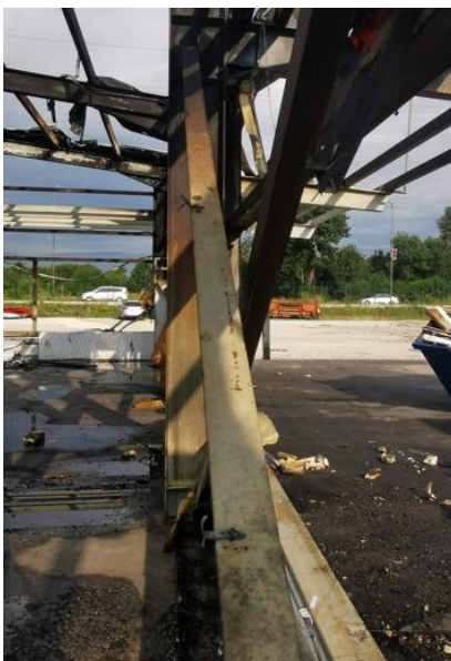
Фиг. 3.3. Голямо разстояние между ъгловите профили на вертикалната връзка
