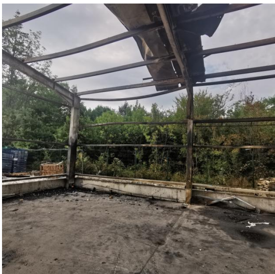
Фиг. 3.2. Компрометираны столици и водачи в крайно междуосие
