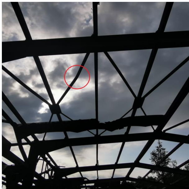
Фиг. 3.4. Деформирани диагонални елементи от хоризонталната връзка
