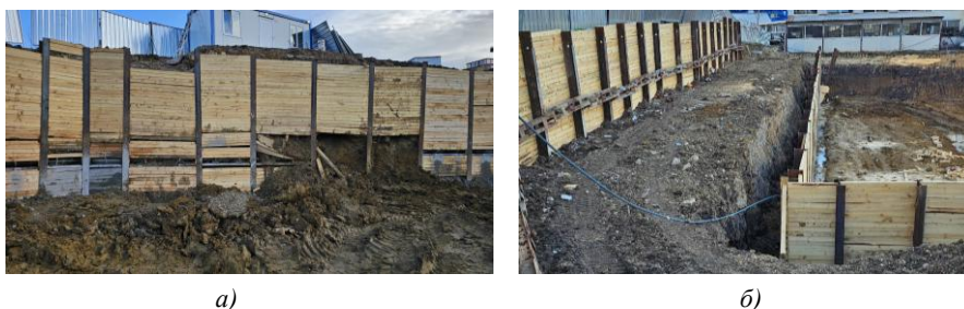
Фиг. 2. Берлинската стена преди да е направен обратен насип
