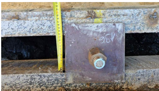
Фиг. 4. Планки в главите на анкерите а) проект; б) изпълнение
