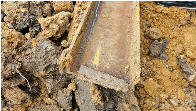
Фиг. 7. Снаждане с недостатъчна носеща способност
