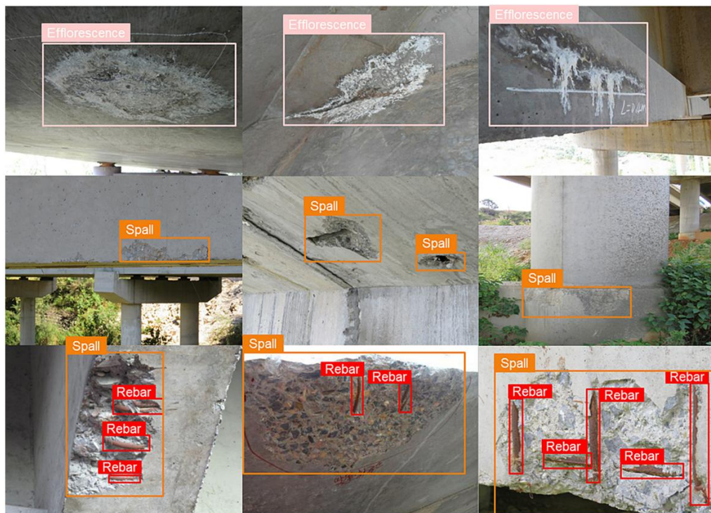
Фиг. 4. Примери за различни видове повреди в стоманобетонни мостове, автоматично локализирани [16]
