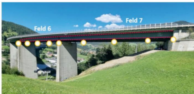
Фиг. 3. Разположение на нишковооптични измервателни трасета в червено и в оранжево на измервателните призми [10]
