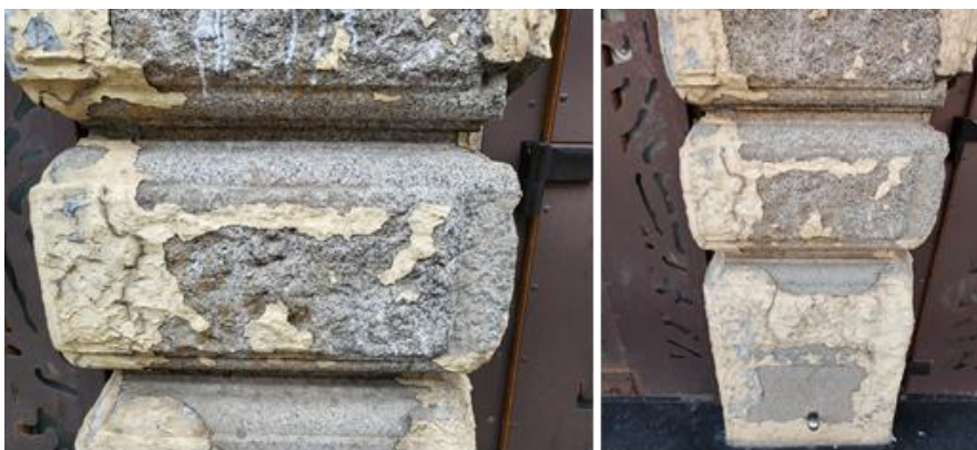
Фиг. 6. Монолитен блок от Витошки монцонит – елемент от фасадните рамки по бул. „Мария Луиза“
