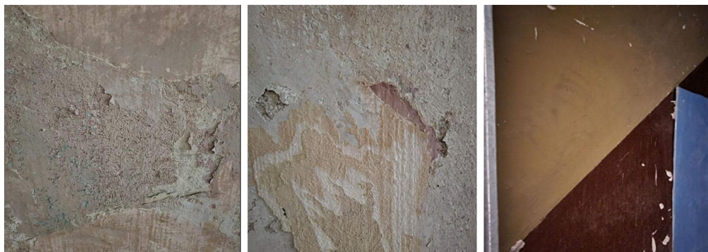
Фиг. 10. Състояние на мазилки и следи от тапети. Оцветяването на стените на стълбищните рамена е в два контрастни цвята
