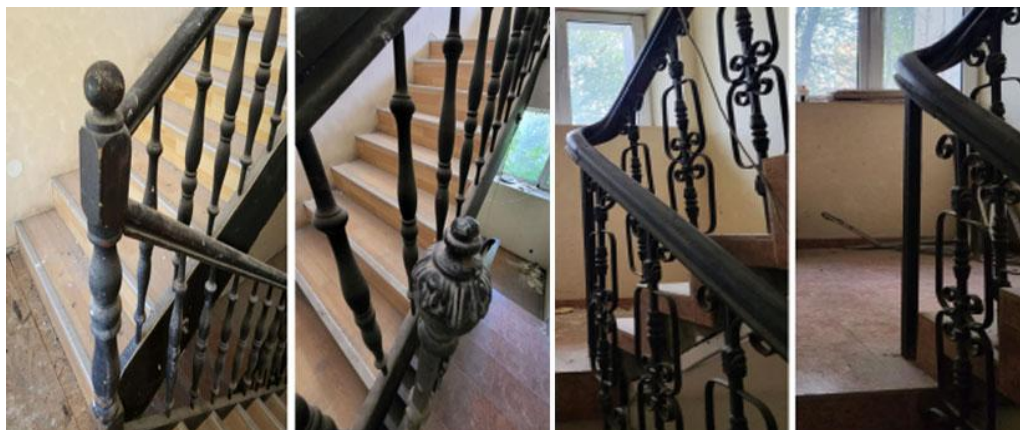
Фиг. 4. Автентичен детайл на парапет от дървесен масив и метал – етажи
