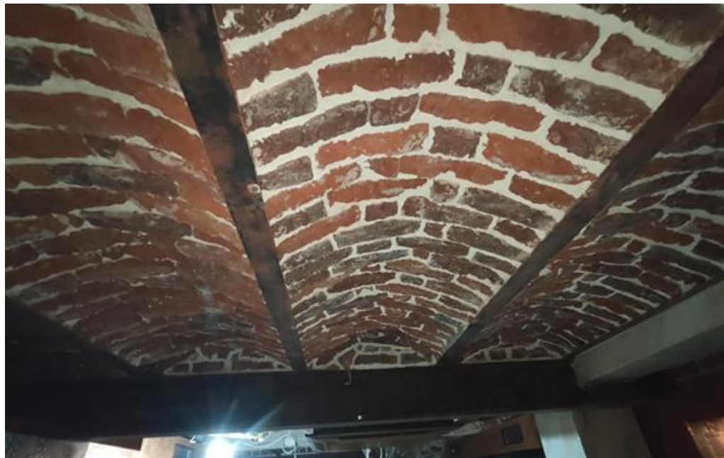
Фиг. 3. Подова конструкция на партерна (първа) плоча тип „Пруски свод“
