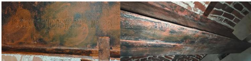
Фиг. 7. Стоманени профили, изработени от фирма „Gutehoffnungshütte“
