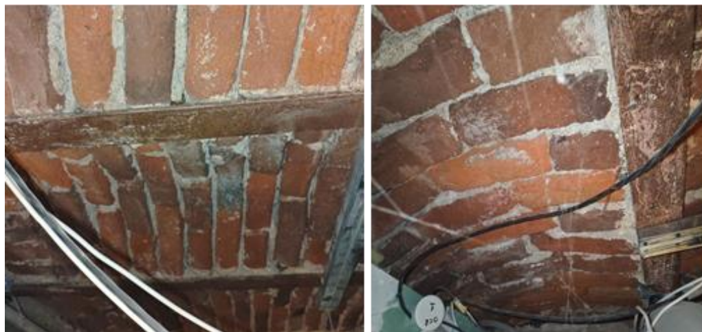
Фиг. 5. Изглед от зидарията на „Пруския свод“ в сутеренното ниво на сградата
