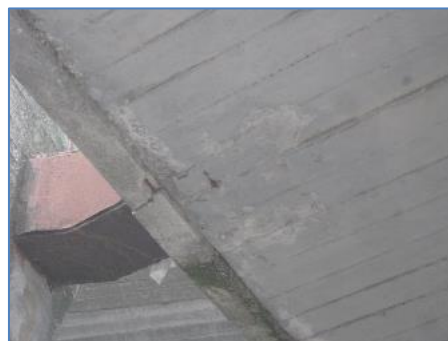
Фиг. 4. Пукнатини по плоскости около пръстена
