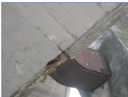
Фиг. 3. Корозия по стоманен пръстен
