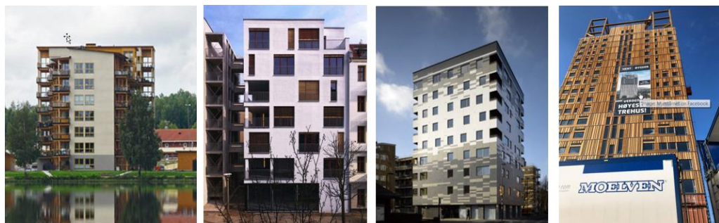
Фиг. 1. Високи сгради с изцяло дървена носеща конструкция с местонахождение и година на пускане в експлоатация: Векшьо, Швеция (2008); Берлин, Германия (2008); Лондон, Великобритания (2010); Брумундал, Норвегия (2019) [1, 2]
