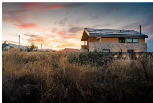
Фиг. 17. ММХХ, Къща Y, поглед от двора, 2018 г. [24]
