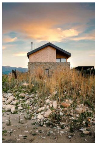
Фиг. 20. ММХХ, Къща Y, поглед от двора, 2018 г. [27]
