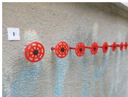
Фиг. 11. Общ вид на монтираните дюбели във фасаден панел „Тип 1“
