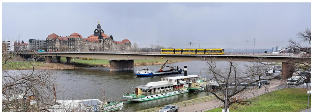
Фиг. 1. Изглед към моста [1]
