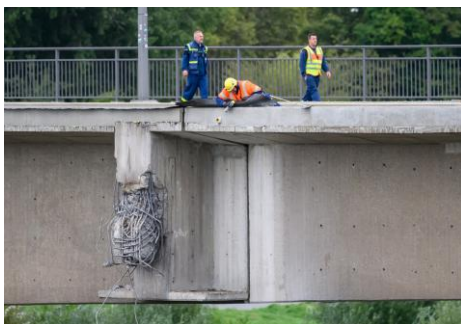
Фиг. 4. Напречна връзка при герберова става [3]
