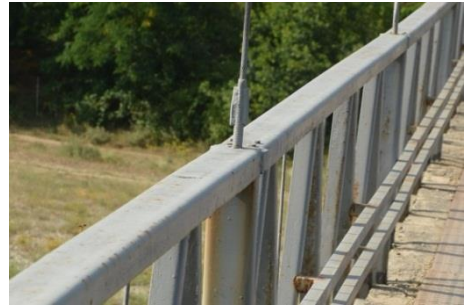
б) на ниво горен пояс закоравяваща греда
