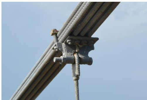
Фиг. 7. Варианти на връзка въжета – окачвач
