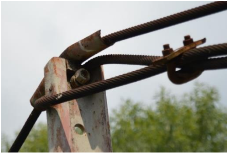
Фиг. 8. Варианти на връзка окачвач – пътното платно
