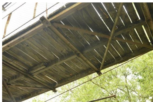
б) с непълно хоризонтално укрепване
