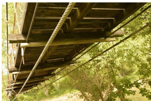
а) без хоризонтално укрепване
