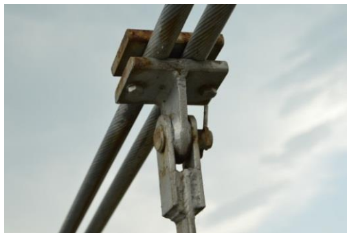
Фиг. 7. Варианти на връзка въжета – окачвач
