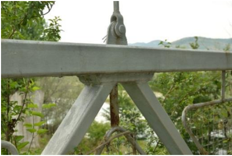
б) на ниво горен пояс закоравяваща греда
