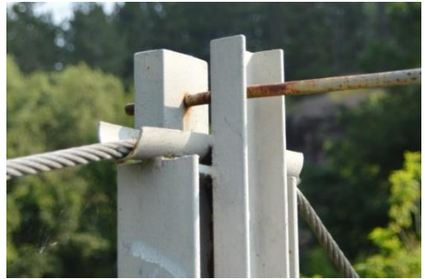
Фиг. 8. Варианти на връзка окачвач – пътното платно
