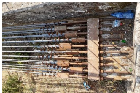
Фиг. 9. Начини на закотвяне на въжетата
