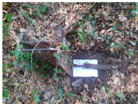
Фиг. 10. Закотвяне на главен кабел – дефекти и локално разрушение
