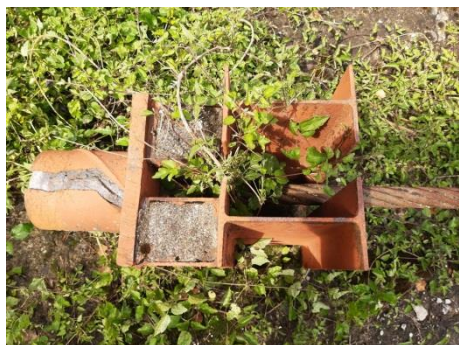
Фиг. 10. Закотвяне на главен кабел – дефекти и локално разрушение
