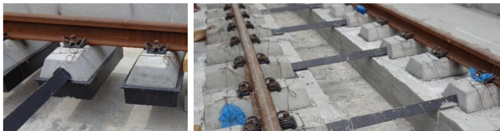
Фиг. 1. Конструкция на горното строене при метрополитена
