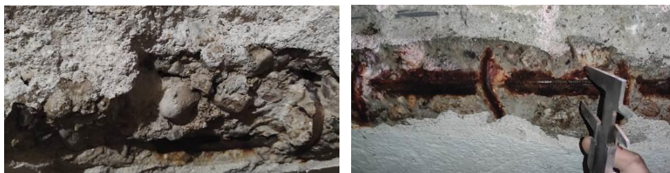
Фиг. 12. Степен на корозия в армировка на греди на партерна плоча
