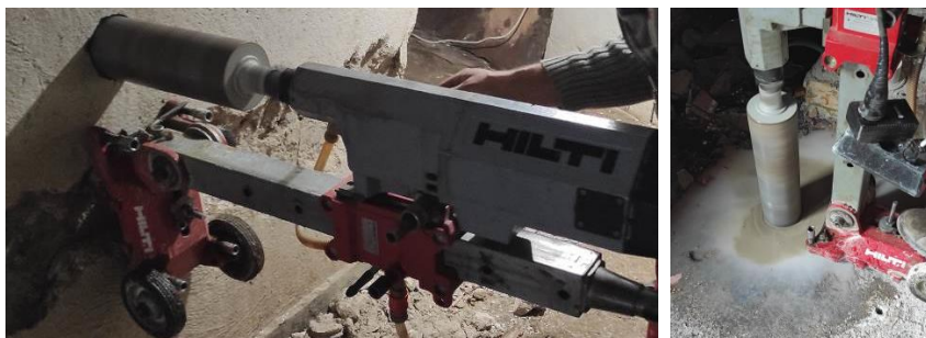
Фиг. 3. Изрязване на сондажни ядки от сутеренна стена и плоча
