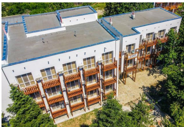
Фиг. 6. Бивше поделение № 66 920 на „Строителни войски“ – гр. Велико Търново – фасада след преустройството. Източник: https://bolgarcapital.com/bolgar-veliko-turnovo/
