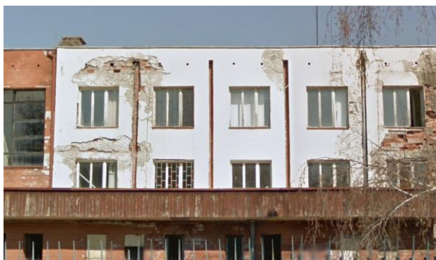
Фиг. 5. Бивше поделение № 66 920 на „Строителни войски“ – гр. Велико Търново – фасада преди преустройството. Източник: https://bolgarcapital.com/bolgar-veliko-turnovo/
