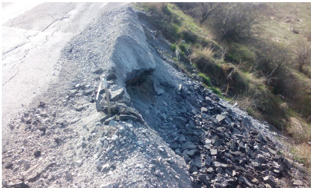
Фиг. 1. Деформации по пътното трасе
