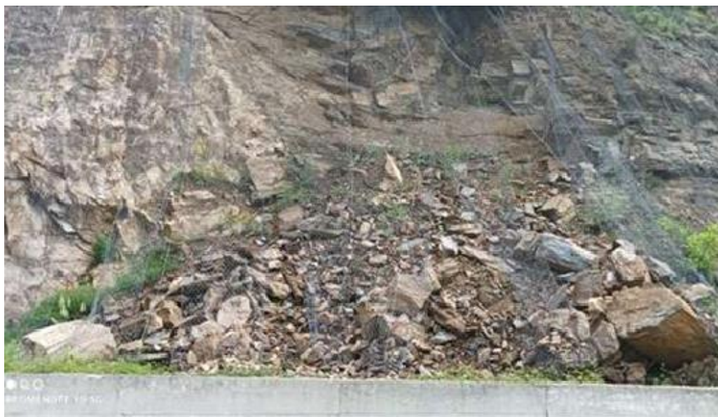
Фиг. 4. Паднала скална маса и компрометирана телена мрежа
