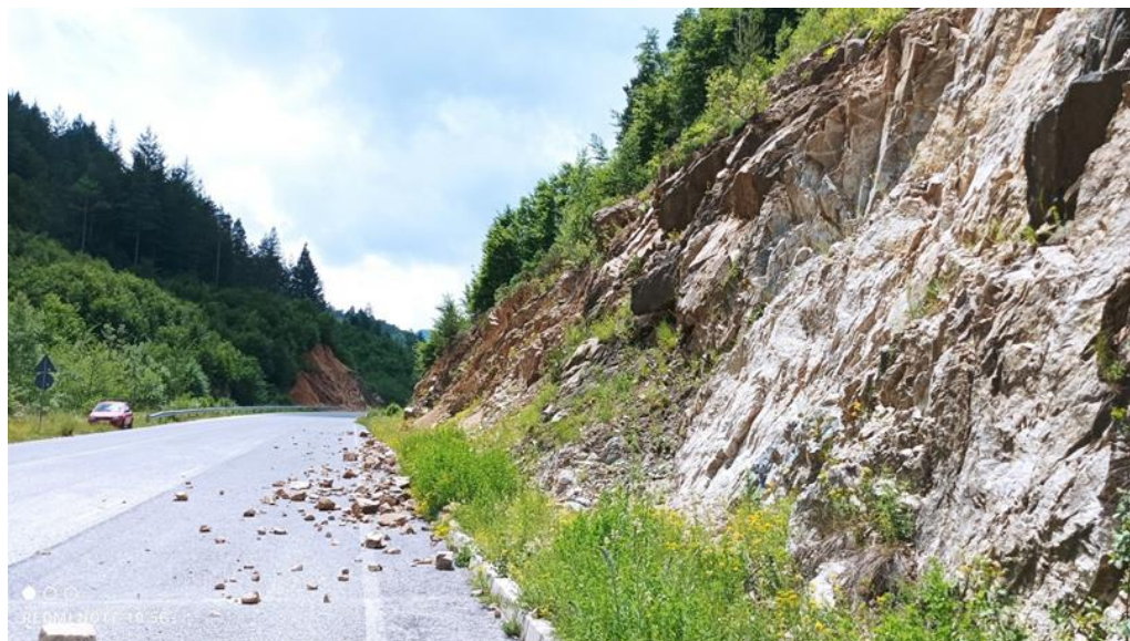
Фиг. 2. Паднали скални блокове върху пътното платно
