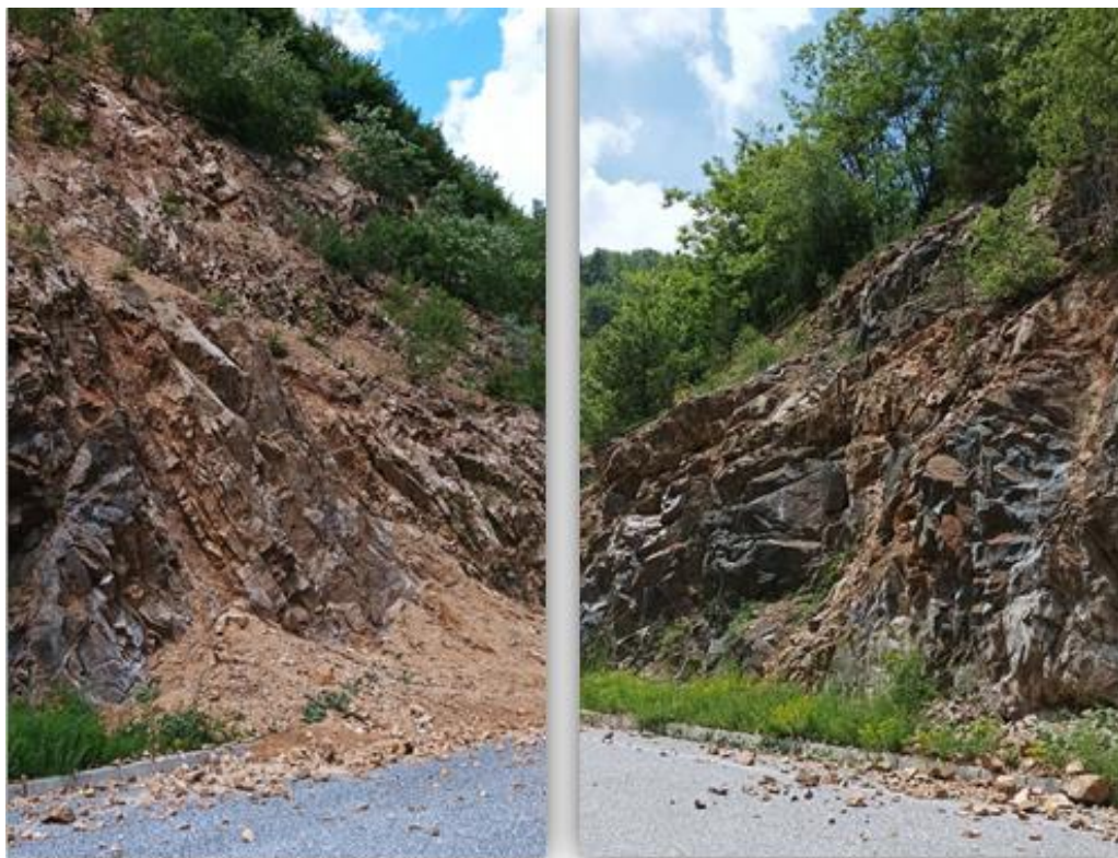
Фиг. 1. Сипеи в пътната лента (вляво) и обрушени скални късове (вдясно)
