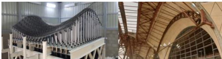
Фиг. 2. Адаптивна кофражна система [5]
