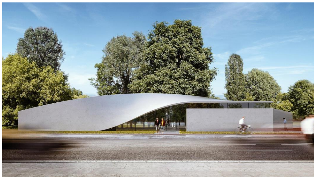
Фиг. 7. Сграда, изпълнена от карбонбетон [32]
