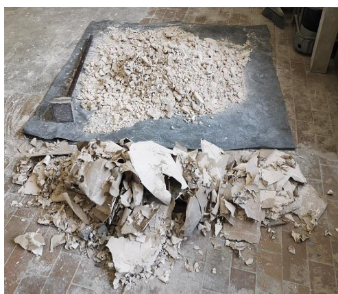
Фиг. 1. Отделяне на картоната и натрошаване на гипса
