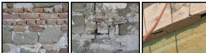
Фиг. 6. Компрометиране на варови зидарийни разтвори
