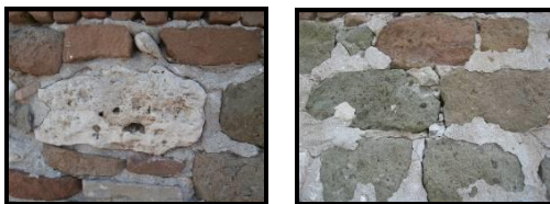
Фиг. 3. Нарушена адхезия на разтворната компонента и зидарийните тела
