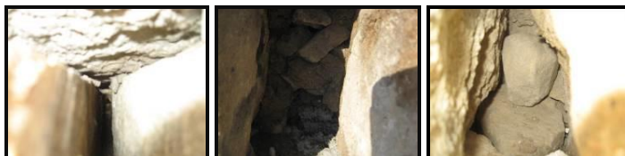
Фиг. 7. Проникване на вода в ядровата зона на зида
