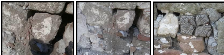
Фиг. 4. Разрушаване на разтворната компонента на зидарията
