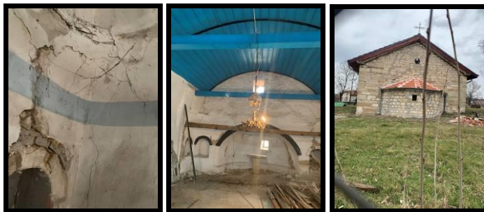
Фиг. 10. Неравномерно слягане на основата под фундаментите
