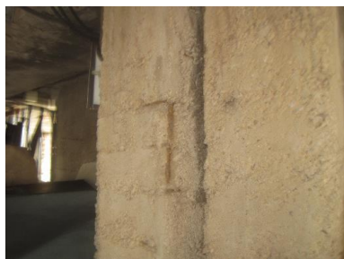
Фиг. 2. Елементи в складово помещение
