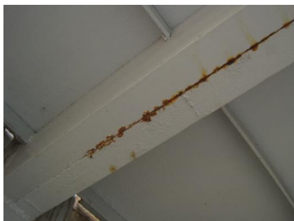
Фиг. 9. Корозия в стоманено стълбище
