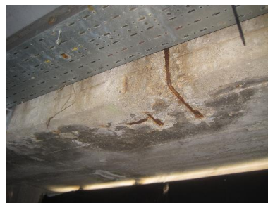
Фиг. 3. Елементи в складово помещение
