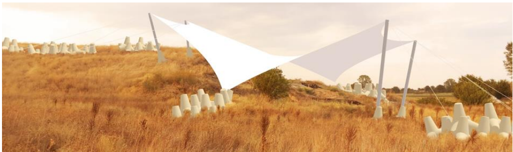
Фиг. 13. Могила „Юнаците“ със защитната мембранна конструкция [10]
