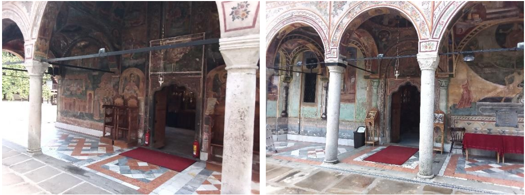
Фиг. 3. Външни метални обтегачи в църквата „Успение Богородично“ на Троянския манастир: (а) Западна галерия, (б) Северна галерия
