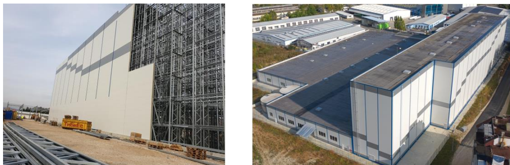
Фиг. 7. Автоматизиран склад без пряка работа на персонал на фирма „Калинел“ (инженеринг: STAMH [12])
