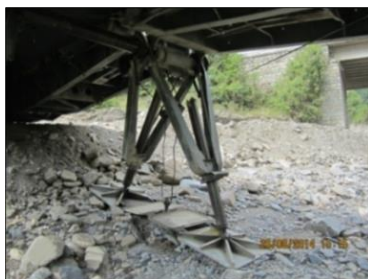
Фиг. 9. Ригел-козлова опора на ТММ-3М
