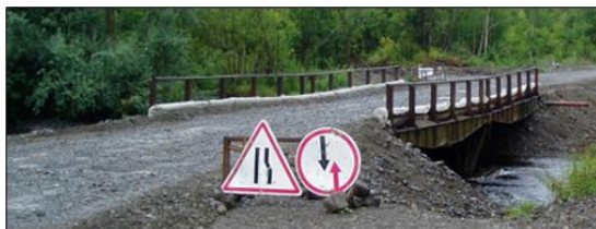
Фиг. 8. Полагане на допълнителна настилка върху горния пояс на мост ТММ, Русия 2015 г.
