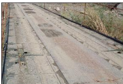
Фиг. 10. Задържане на повърхностни води по пътното платно на ТММ-3М, с. Батулия
