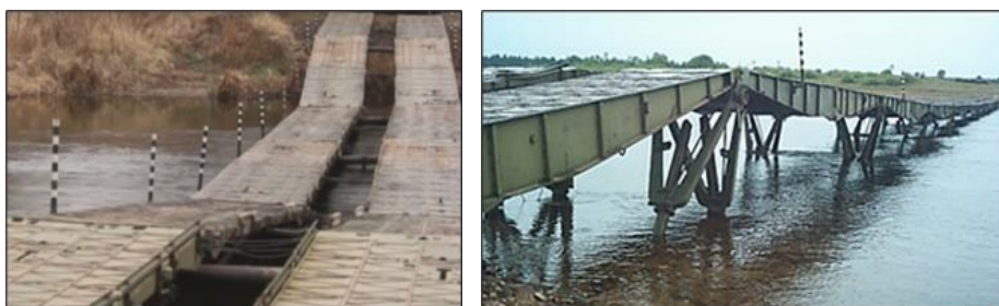
Фиг. 11. Наклонено входно звено и повдигната средна част на ТММ-3М
