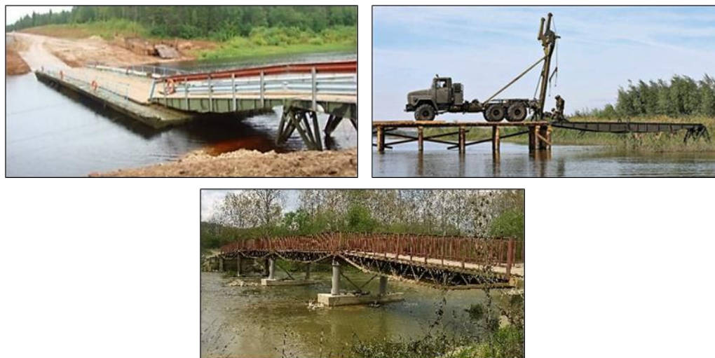
Фиг. 14. Комбинирани мостове, включващи автомобилен механизирен мост
