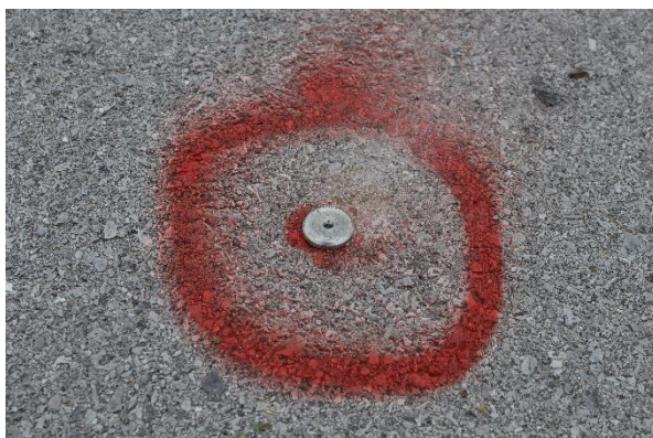
Фиг. 10 Немагнитен болт, поставен в една от фиксираните реперни точки на площадката
