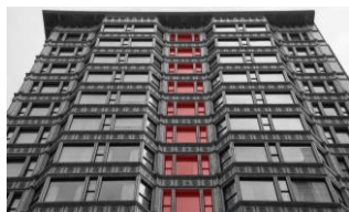
Фиг. 26. Фасадно членение на сграда със скелетна конструкция – Рилайънс Билдинг (1) и сграда с носещи стени – Монаднок Билдинг (2)
