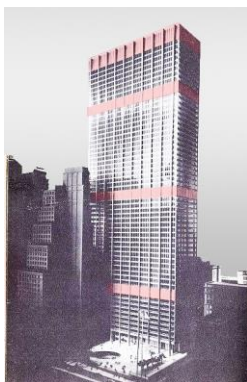
Фиг. 32. Чейз Манхатън Плаза – подчертаване на различната функция на етажите във фасадното оформление
