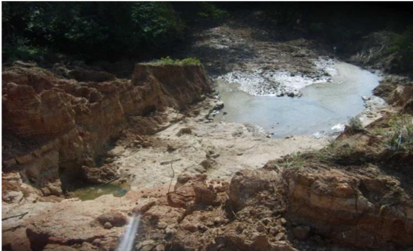
Фиг. 8. Скъсването на язовирната стена на язовир „Езерче-2“ вследствие на преливане през короната. Дата: септември 2007 г. Автор: експерт от общ. Цар Калоян
