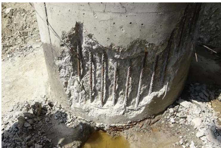
Фиг. 5. Неравномерно разпределение на стремната и малък диаметър
