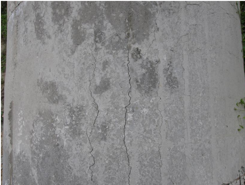
Фиг. 4. Корозирала армировка, напречна и надлъжна
