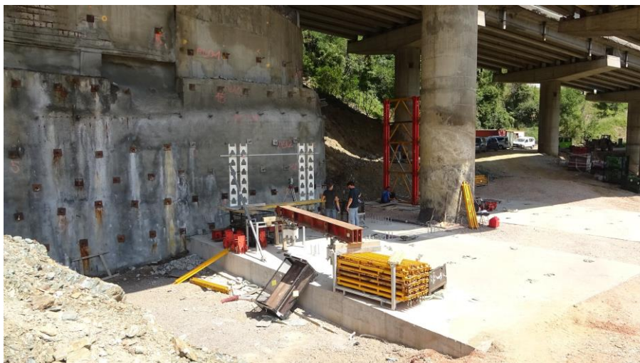
Фиг. 20. Завършена анкерна стена с фундаментни плочи за тежко скеле
