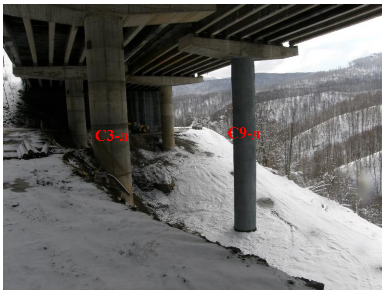
Фиг. 11. Дълбок изкоп за дясно платно – \Delta H = 11 m
