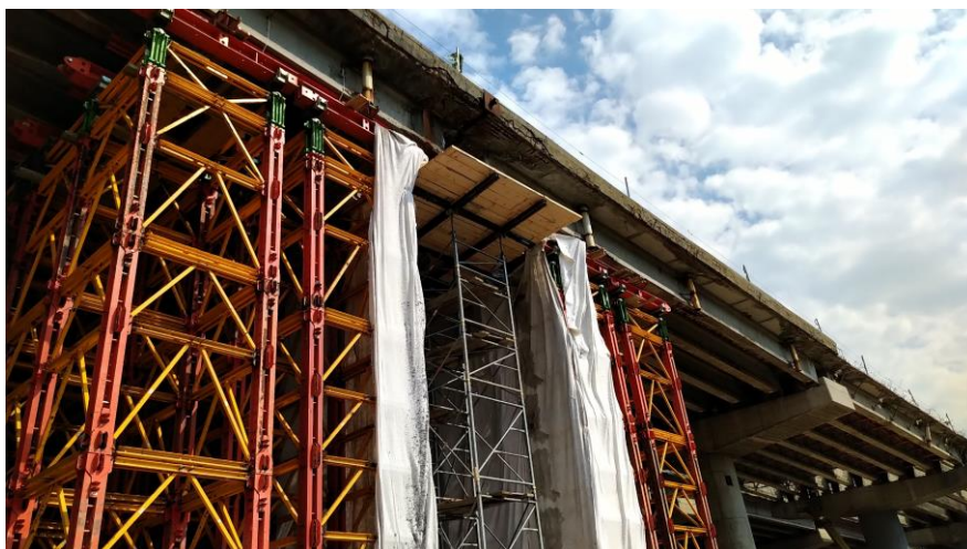
Фиг. 21. Специализирано скеле и опорно скеле за ригела
