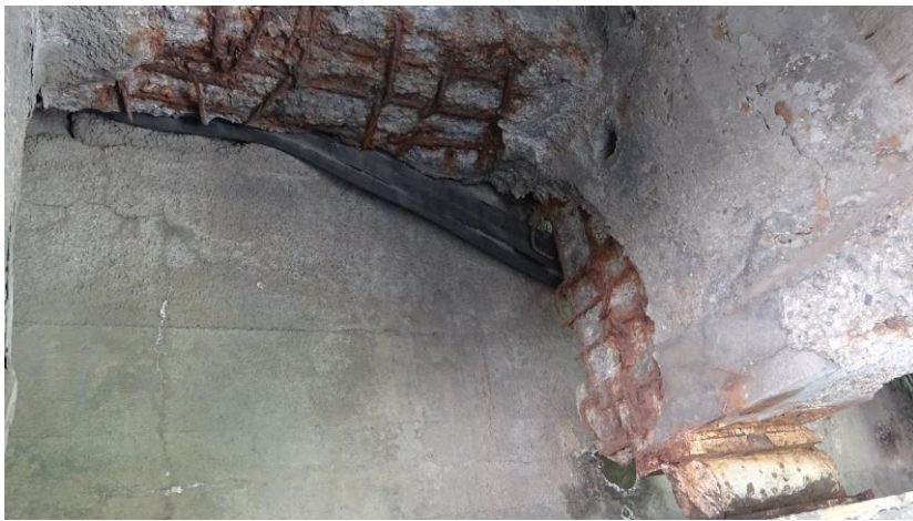
Фиг. 9. Повреди при греди вследствие от течаща агресивна вода през дилат. фуги и воронки
