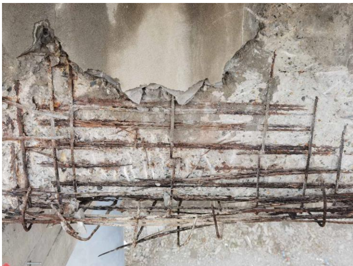
Фиг. 26. Повреди при налягнати греди – скъсана налягателна армировка
