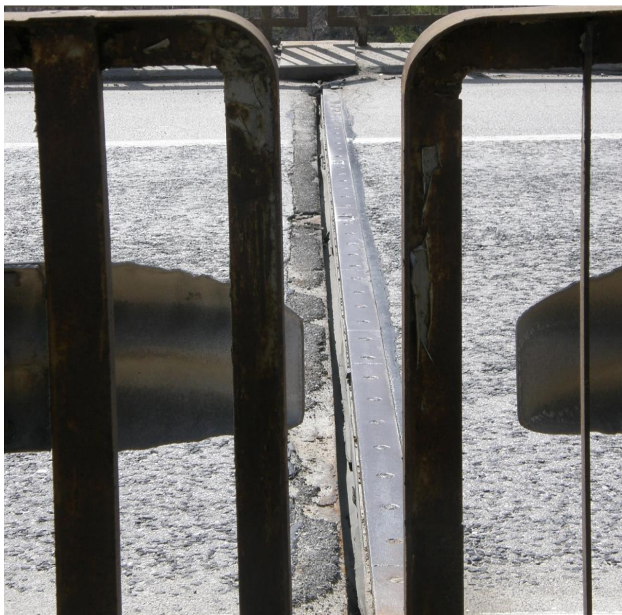
Фиг. 7. Липса на изолационен еластомер – фуга над ригел на стълб С6-д
