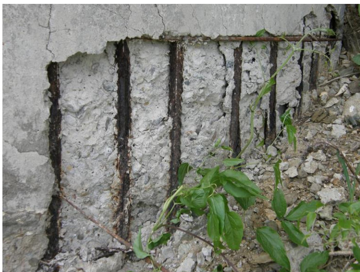
Фиг. 6. Използван е едър добавъчен материал с речен произход, невибриран бетон
