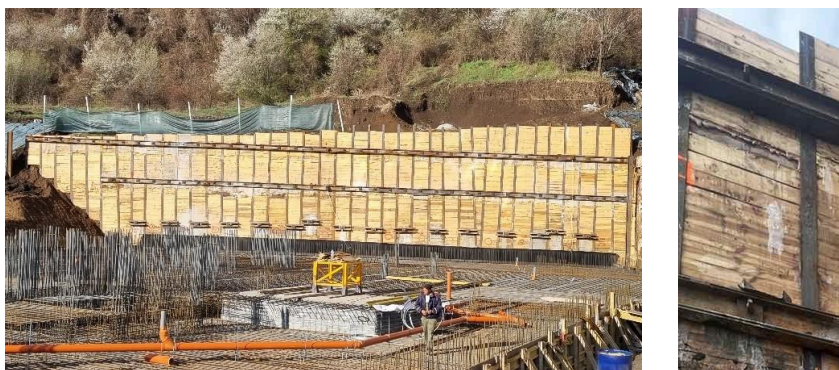
Фиг. 2. Укрепителна стена в гр. София и анкерни дози
