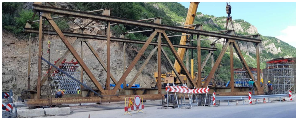
Фиг. 5. Средната секция с маса 77 тона е свалена!
