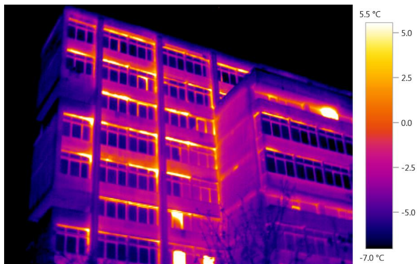
Фиг. 3. Южна фасада на УАСГ, гр. София – вечерна инфрачервена термография
