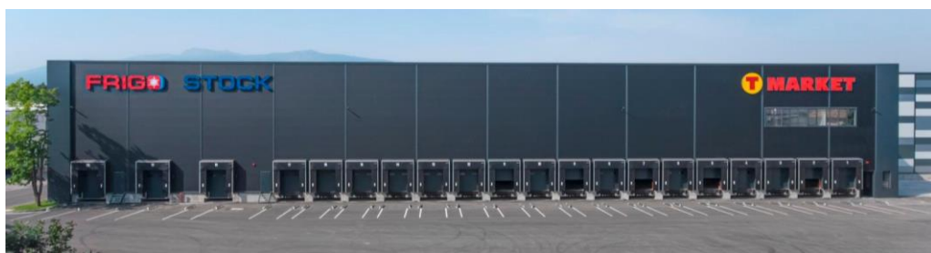
Фиг. 7. Северна фасада на сградата на Хладилна база Frigo Stock
