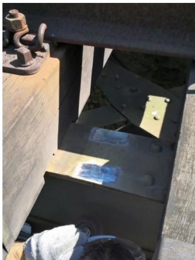
а) зачистване на поясите на надлъжните греди
