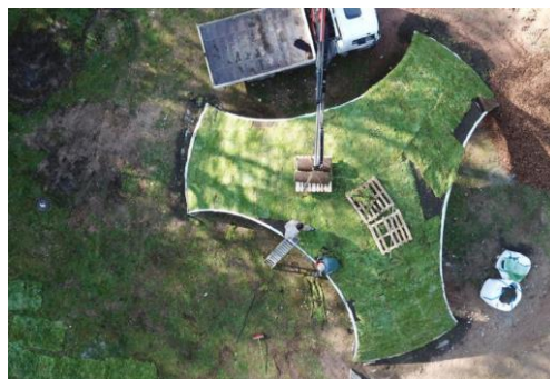
Фиг. 7. Изпълнение на покривно тревно покритие “Recycleshell“, Университет Кайзерслаутерн, Германия [6].
