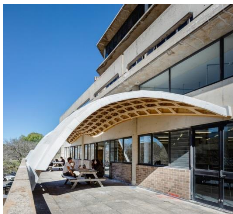
Фиг. 8. Слънцезащитна конструкция “HexBox Сапору“, Университет Кайзерслаутерн, Германия, снимка Катерин Лу [7]
