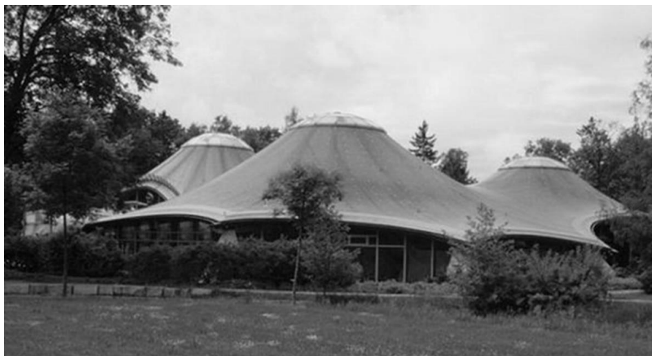
Фиг. 19. Изглед към сградата на басейна, Бад Дурхаим, Германия / Geier & Geier, Stuttgart [10]. Източник: www.burgbacher.de
