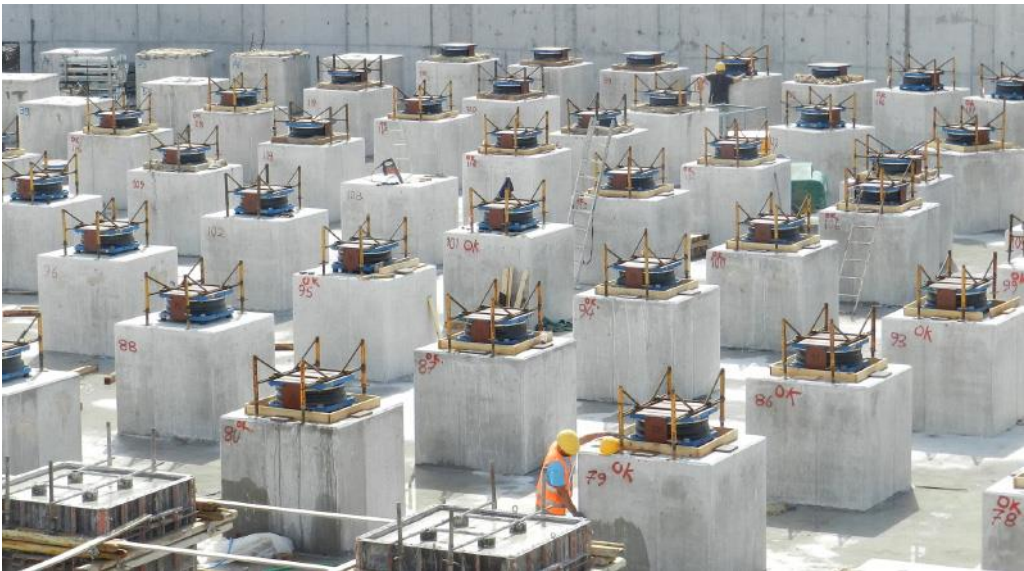
Фиг. 5. Въртящ се сачмен лагер, Енка Technologies Company.
