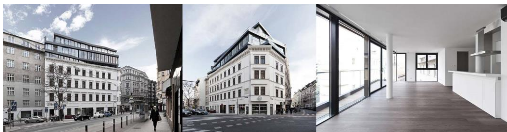
Фиг. 2. Вертикално надстрояване жилищна сграда, Виена, Австрия. Източник: A Touch of Contemporary – Hilton Garden Inn, http://www.fasadehunters.com
