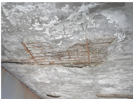
Фиг. 7. Състояние на стоманобетонните панели – нарушено бетонно покритие и силно кородирала армировка, две години след извършен ремонт [16]
