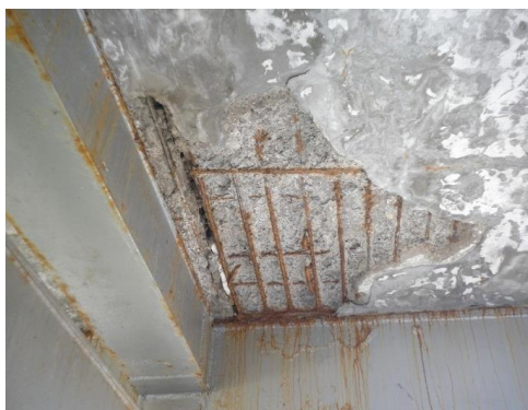
Фиг. 7. Състояние на стоманобетонните панели – нарушено бетонно покритие и силно кородирала армировка, две години след извършен ремонт [16]
