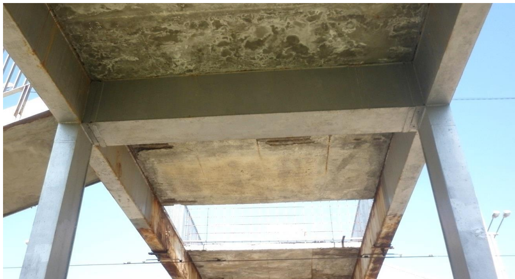
Фиг. 2. Корави възли между главните греди, напречните греди и колоните при междинна опора
