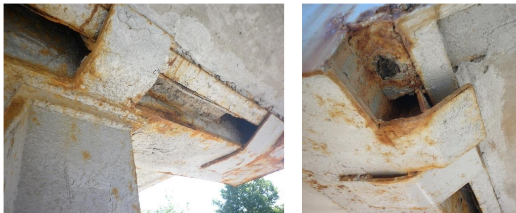
Фиг. 15. Интензивна корозия по стоманените елементи и части на стълбищата
