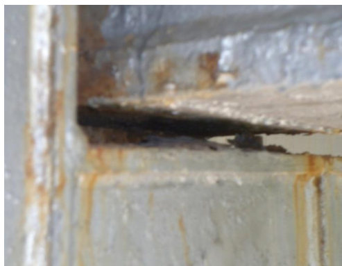
Фиг. 6. Интензивна корозия в краен опорен възел на главната греда
