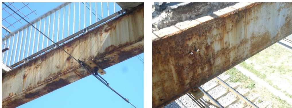
Фиг. 10. Интензивна корозия на стоманената главна греда
