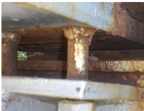
Фиг. 6. Интензивна корозия в краен опорен възел на главната греда
