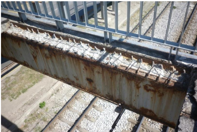
Фиг. 5. Интензивна корозия във фугата между панелите от пътното платно и водобранния ъглов профил (в този участък панелът вече е паднал!)
