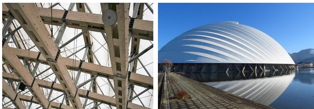
Фиг. 3. Спортната зала за бейзбол, Odate Jukai Dome Park, Jappan, 1997 г. Проектанти: Toyo Ito & Associates Architects, Taneka Corporation. Главна носеща конструкция от двупоясна мрежеста черупка от дървени и стоманени профили и двуслойна текстилна мембрана с вълнообразна форма. Източник: http://www.proholz.at/architektur/detail/odate-jukai-dome-park/ , посетен на 12.04.2019 г.
