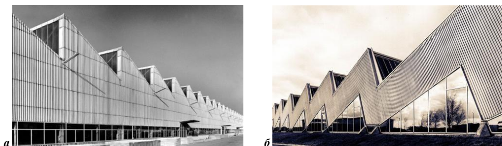
Фиг. 3. Решения на индустриални сгради, в които шедовият покрив, изявен и във фасадите, е доминиращ в архитектурната композиция: а – фабрика на компанията „Етернит“ (1954 – 1960) в Лейнмен, Германия, арх. Е. Нойферт [4]; б – фабрика за мотори Куминс
