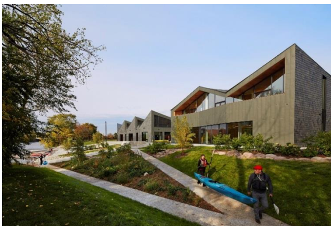
Фиг. 12. Ориентация на шедовото остъкляване, позволяваща ослънчаване през зимата [9]
