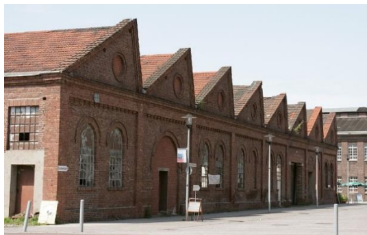
Фиг. 1. Стари индустриални сгради с шедова покривна конструкция [1, 2]
