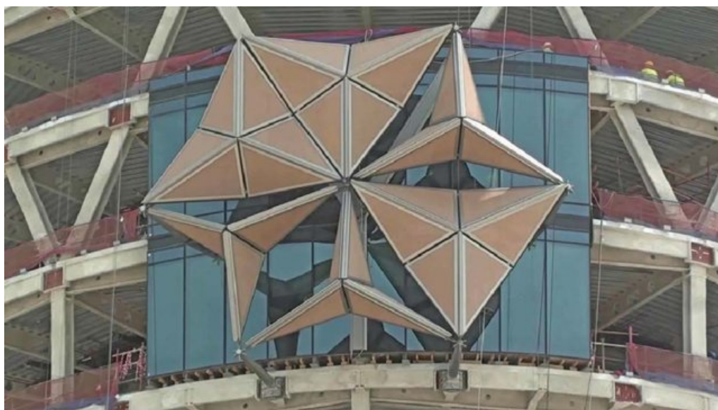
Фиг. 5. Поставяне на засенчващите елементи машарабуя. Виждат се металните конзоли, които служат за закрепване на елементите.
