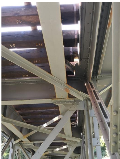
а) корозия по ръбовете на надлъжните греди и в горната противовеетрова връзка
