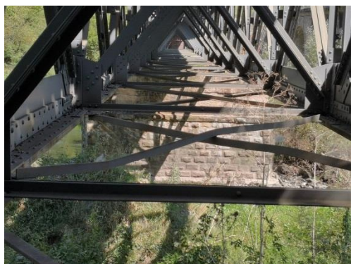
а) изкривени диагонали в долната противовеетрова връзка
