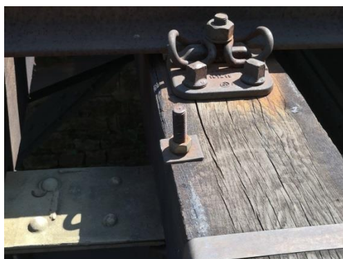
в) лапчат болт много близо до ръба
