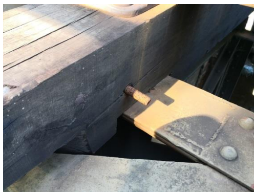
а) липсващи гайки
