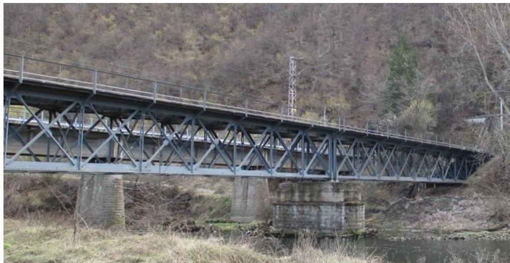
Фиг. 1. Общ вид на изследвания стоманен мост – на km 18 +985
