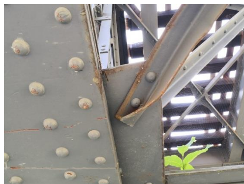
б) ударен диагонал и нитове по долния пояс на моста
