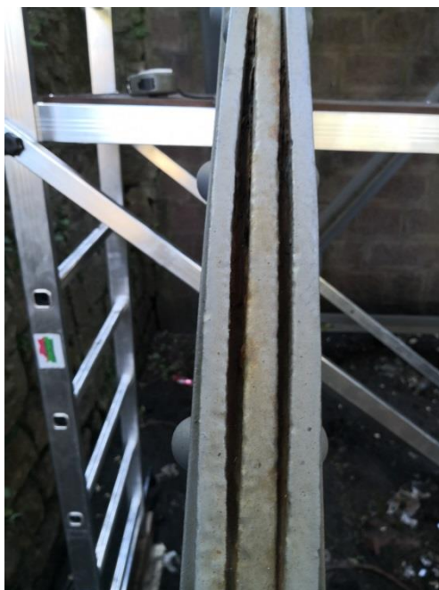
б) разтваряне на шините в опънните диагонали на прътовите главни греди
