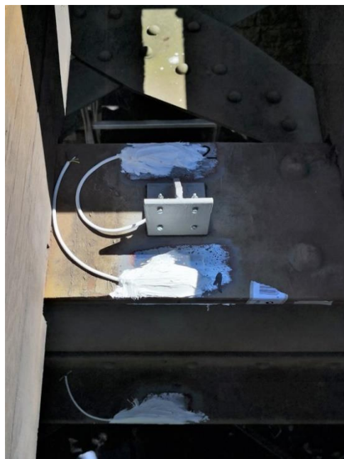
г) защита на тензометричните датчици
