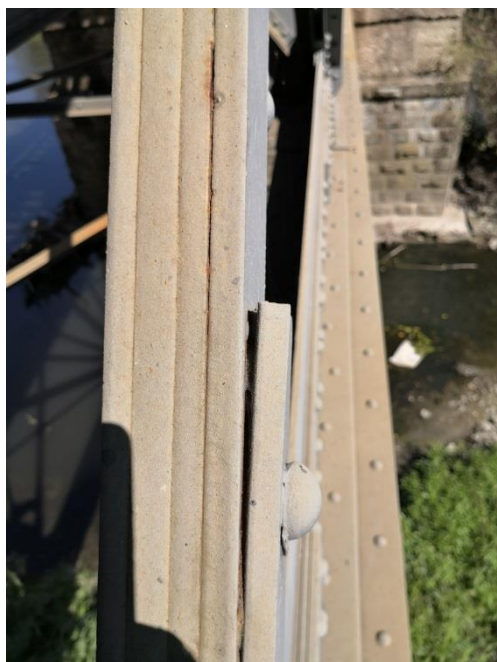
а) отделяне на възловата плоча от диагонала
