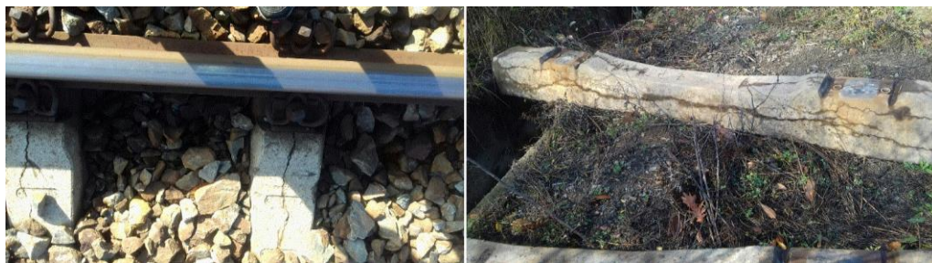
Фиг. 8. Компрометирани траверси в участък Вакарел – Веринско
