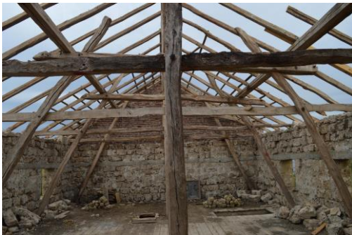
Фиг. 10. Моменти от ремонта на дървената покривна конструкция [1]
