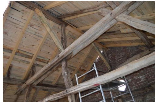
Фиг. 10. Моменти от ремонта на дървената покривна конструкция [1]
