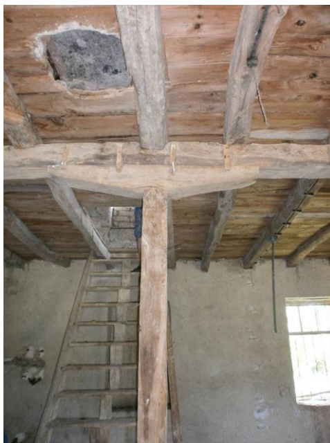
Фиг. 4. Общ вид на част от дървената конструкция в сградата [1]
