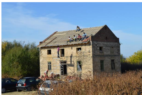
Фиг. 12. Момент от ремонта на покрива [1]
