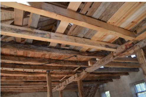
Фиг. 11. Подмяна и усилване на дървената конструкция вътре в сградата [1]
