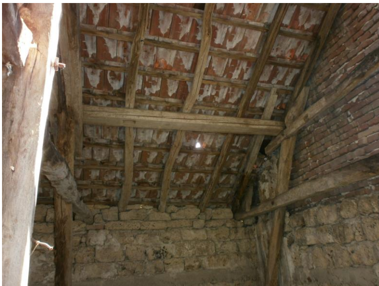
Фиг. 3. Общ вид на част от покривната конструкция [1]
