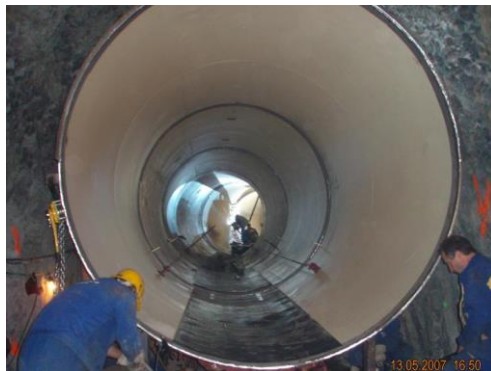
Снимка 13. Разширение на ВЕЦ Студен кладенец 2007 г. – монтаж на панцеровка
