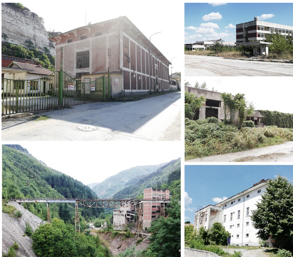
Фиг. 3. Примери за неизползвани индустриални сгради: Промислени сгради в гр. Никопол (горе ляво); Промислени сгради до нефункциониращ рудник край бившето с. Фабрика (долу ляво); (дясно от горе надолу): Авторемонтна база край гр. Червен бряг; Завод за мебелни плоскости гр. Септември; Фабрика за преработка на тютюн в гр. Златоград
