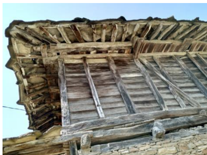
Фиг. 21. Изглед на втория етаж от сграда, с груба обработка на дървото, село Старо Стефаново, 2019 г.
