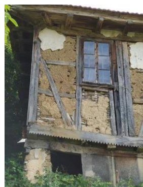
Фиг. 27. Детайл на плет, покрит с кал, махала Баба Стана, 2019 г.
