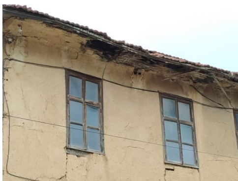
Фиг. 28. Детайл на софита на стрехата, село Бели Осъм, 2019 г.
