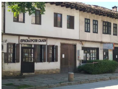
Фиг. 1. Изглед към ансамбъл сгради по ул. „Васил Левски“, Троян, 2019 г.
